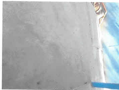
Foto 4: sustitución de torta en mal estado.
