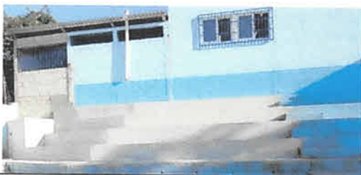
Foto 5: reparación de graderio en mal estado.
